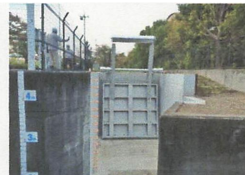
根川第1雨水幹線への逆流防止ゲートの設置
