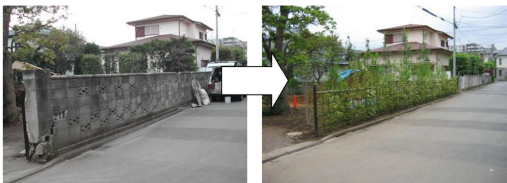
生け垣設置前と設置後（設置例）
