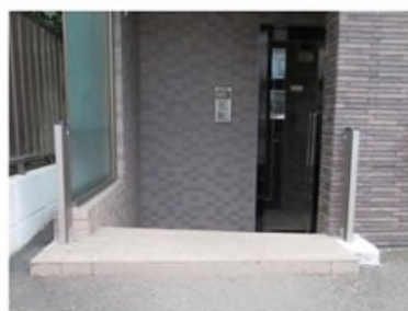
止水板設置前
