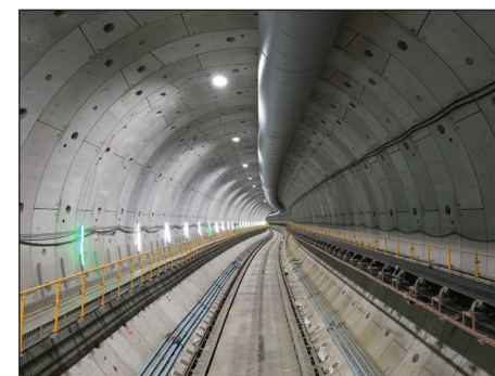
構築されたトンネル内(合成コンクリートセグメント) (令和5年3月28日)
