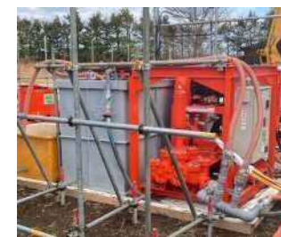
ボーリングポンプ 削孔時の水送り込み
