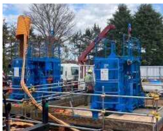
地盤補修マシン 地盤の削孔および改良体の造成
