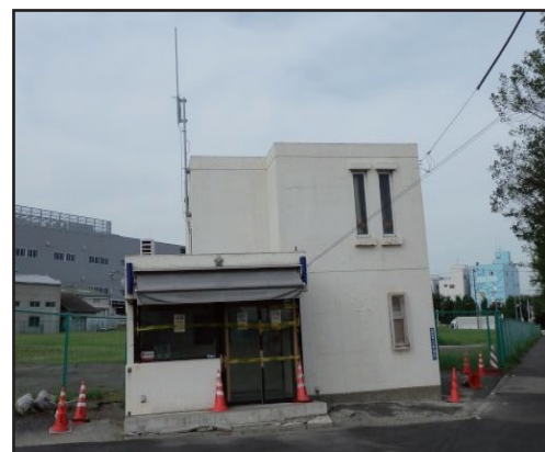
液状化で傾いた建物
