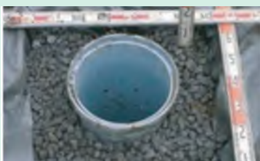
■宅地への雨水浸透ますの設置
