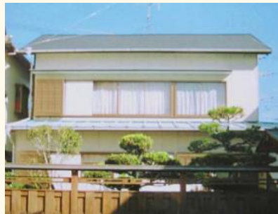
補強後： 化粧スレート葺の軽い屋根に改修
