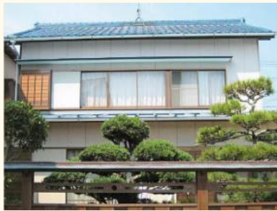
補強前：瓦葺の重い屋根
