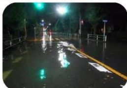
市内における台風による道路冠水の状況 出典:「令和元年東日本台風(台風19号)調布市の記録」(令和3年3月)
