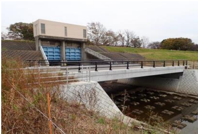
六郷排水樋管
