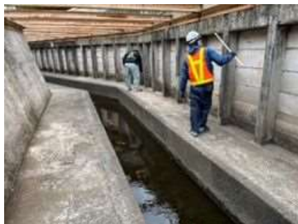
変状調査(点検)
