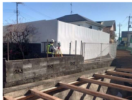
変状調査(測量)
