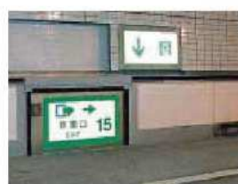
路面下への非常口(路面から)
