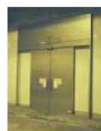
首都高速中央環状新宿線の例
