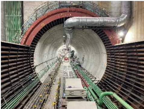
坑内の状況 (令和7年7月30日)
