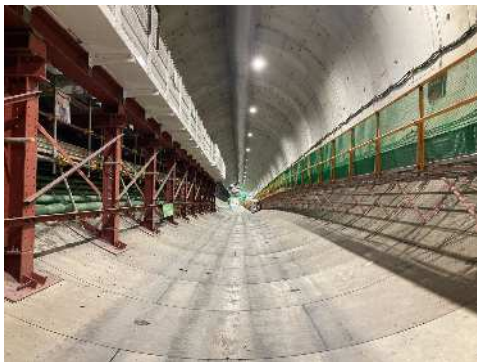
坑内の状況 (令和7年5月30日)
