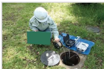
地下水位の観測状況
