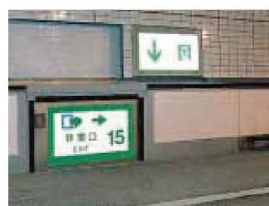
路面下への非常口(路面から)
