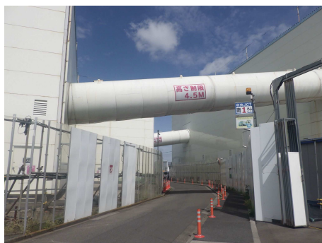
ベルトコンベアの状況 (令和6年4月16日)
