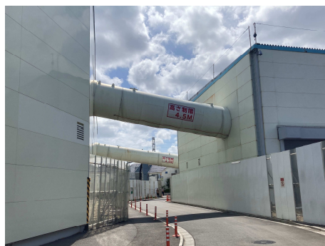
ベルトコンベアの状況 (令和6年4月16日)
